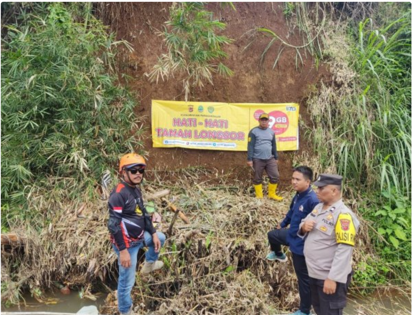
Polsek Parakansalak Gencar Kampanye Keselamatan Banner Peringatan Bahaya Dipasang di Lokasi Rawan
