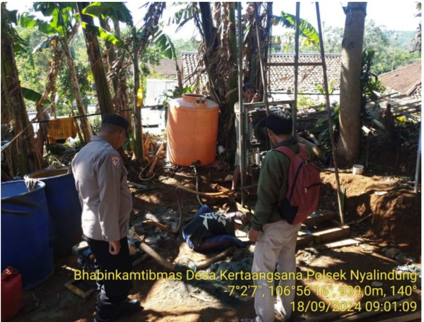
Monitoring Pembangunan Sumur Bor di Desa Kertaangsana oleh Bhabinkamtibmas Polsek Nyalindung
