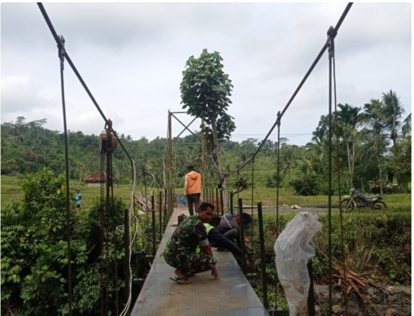
Kpt Arm Witono: Pengerjaan Jembatan Gantung Sudah 80%
