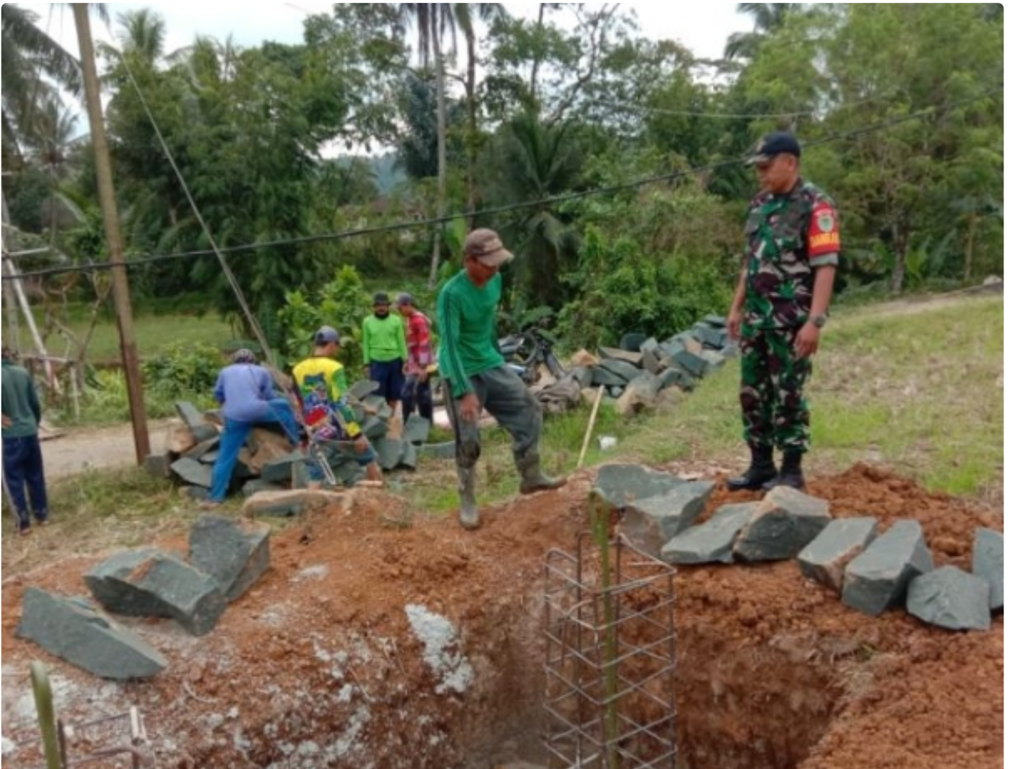
Giat Bakti Pembangunan Jembatan Gantung di Koramil Jampangkulon Bantuan Pangdam III/Siliwangi
