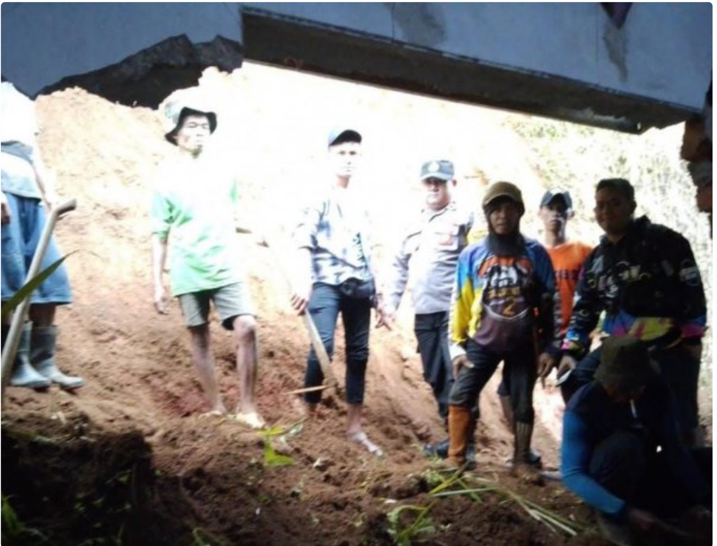
Kesigapan Bhabinkamtibmas Bantu Bersihkan Rumah Warga Akibat Tanah Longsor
