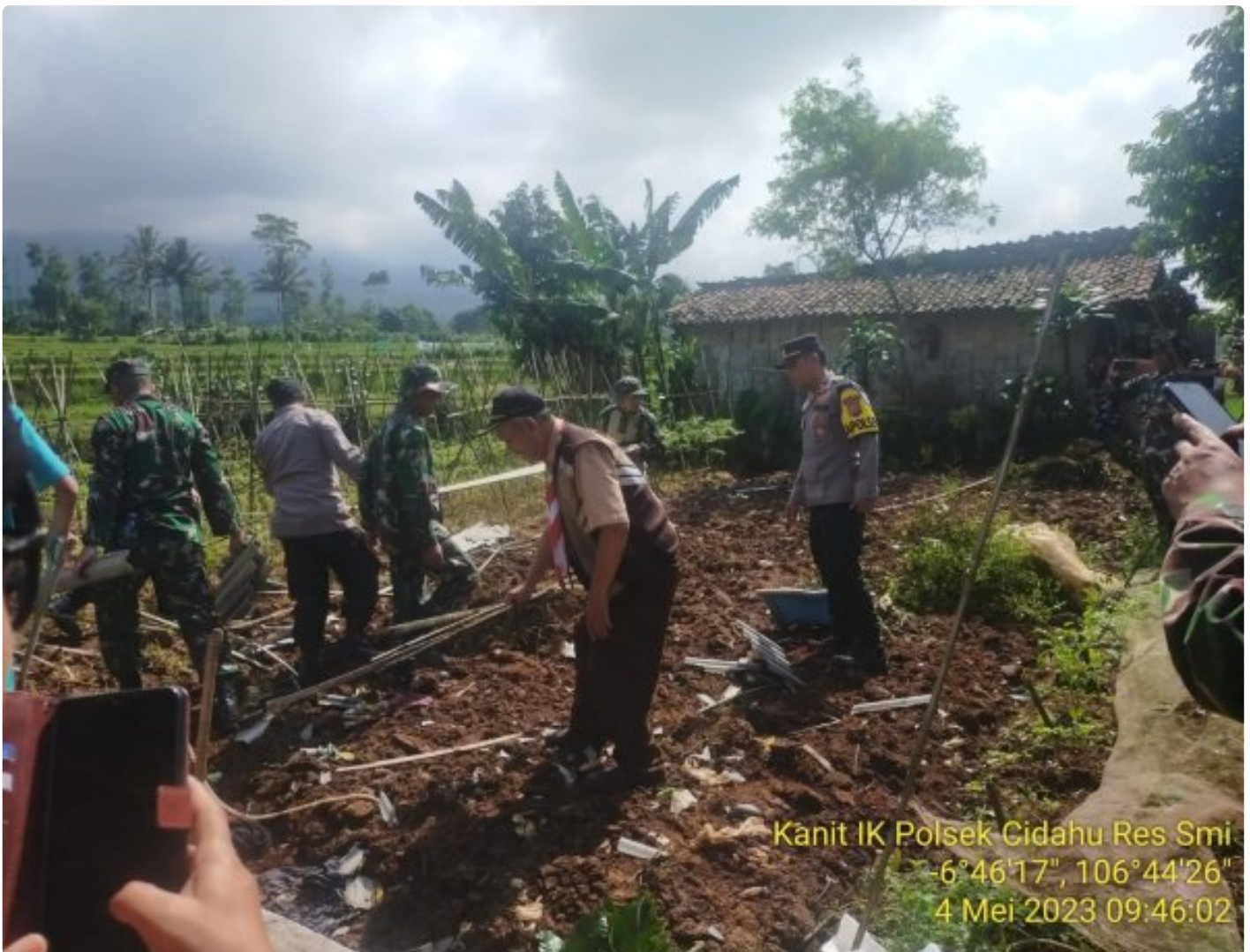
Apel Kesiapsiagaan Bencana Dilanjutkan Gotong Royong Bersihkan Puing Bangunan di Cidahu Sukabumi
