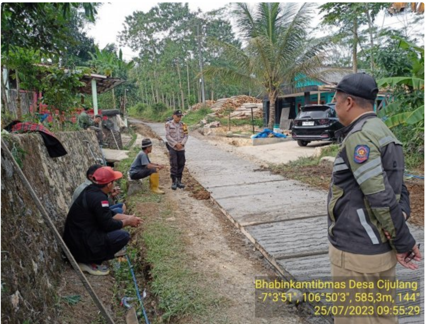
Aipda Sudiro Monitoring Pembangunan MCK di Desa
